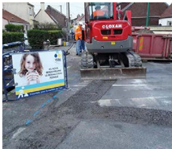
chantier rue à Gravelines
